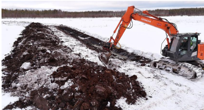
Kaivurityötä talvella ja kesällä
